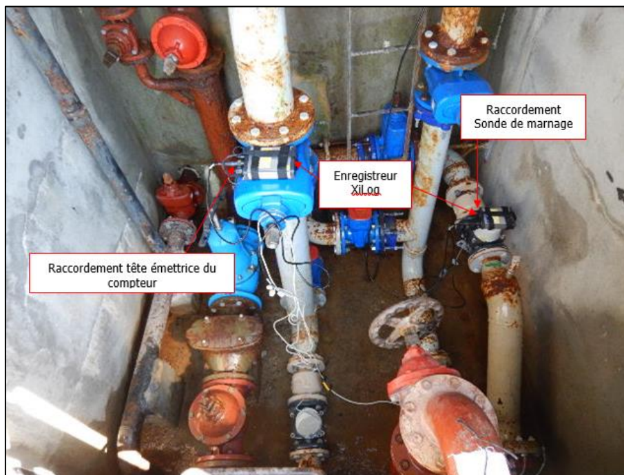
Figure 28 : Exemple de mise en place du matériel de mesure
