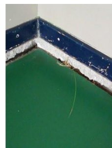
mouvement de sol, détérioration de la dalle
