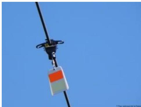
**Figure 2 : Exemple de dispositif anticollision**
