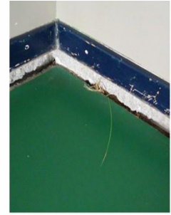
mouvement de sol, détérioration de la dalle
