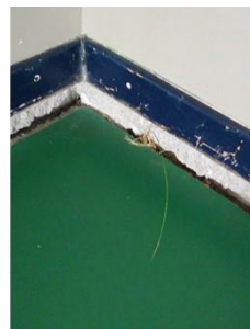
mouvement de sol, détérioration de la dalle
